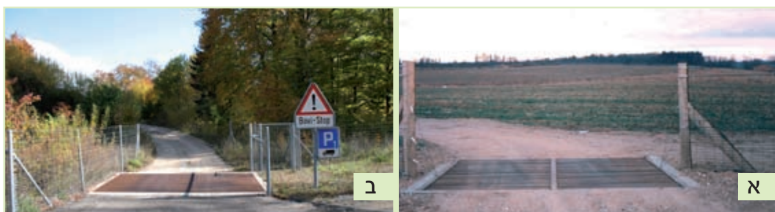
איור 7.76: שימוש במעברי בקר לצד גידור בנקודות שבהן כביש צדדי פוגש כביש ראשי: (א) בדרך חקלאית. דוגמה מדנמרק. (צילום: EU: B. Wandall); (ב) ביציאה מהכביש הראשי לדרך הפונה למעבר עילי רב-שימושי בשוויץ. (צילום: תמר אחירון-פרומקין)
