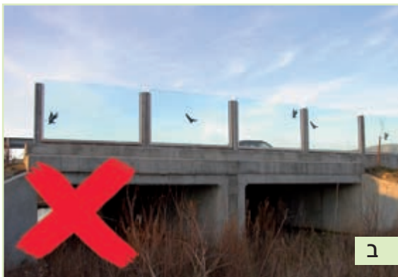
איור 7.82: מחיצות שקופות עלולות לגרום להתנגשויות קטלניות של ציפורים: (א) סימון מחיצות בפסים אנכיים למניעת התנגשות של ציפורים; (ב) סימון מחיצות שקופות בצלליות אחדות של עופות דורסים אינו אמצעי יעיל למניעת התנגשויות של ציפורים. (צילומים: F. Navàs, Minuartia, SP)
