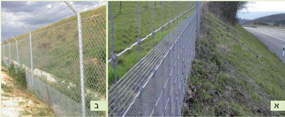
איור 7.71: דוגמאות לשילוב בין סוגי סבכה - גידור משולב למניעת מעבר של כמה מיני יעד: (א) שילוב בין רשת רגילה לבין רשת צפופה יותר בצד החיצוני של גדר, חיזוק המסייע במניעת מעבר של חולייתנים קטנים. (צילום: SP: C. Rosell, Minuartia); (ב) שילוב בין הגבהה למניעת ניתור של איילים לבין חיזוק בתחתית למניעת מעבר של חולייתנים קטנים. כשיש צורך לחסום את המעבר גם לדו-חיים ולזוחלים אפשר לשלב בין גדר אוסטרלית לבין גדר צפופה יותר בתחתית ולבין משטחים אטומים ששוליהם פונים החוצה והם טמונים באדמה עד 40 ס"מ. (צילום: SP: M. Fernández Bou, Minuartia)
