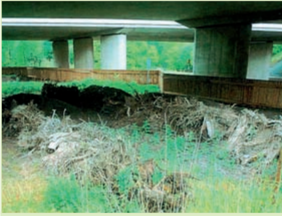
איור 7.42: בולי עץ וערמות ענפים משמשים מחסה לבעלי חיים: מתחת לגשר בכביש A27 בהולנד. ברקע נראה המיסוך המפריד בין כביש מקומי לבין הערמות. (צילום: H. Bekker, EU)
