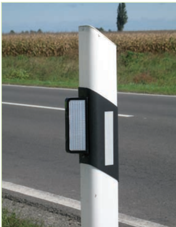
איור 7.77: מחזיר אור שנועד להחזיר את אורות כלי הרכב לסביבת הכביש כדי להרתיע את בעלי החיים מלהתקרב לכביש: דוגמה מהונגריה (צילום: תמר אחירון-פרומקין)
