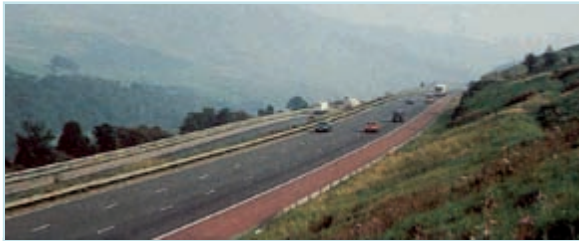
איור 6.3: תוואי כביש העוקב אחר קו רכס ואינו נכנס לעמק הנהר: השוליים שוקמו כך שיצמח בהם צומח האופייני לאזור, קמבריה בצפון אנגליה. (צילום: EU: Highways Agency, UK)
