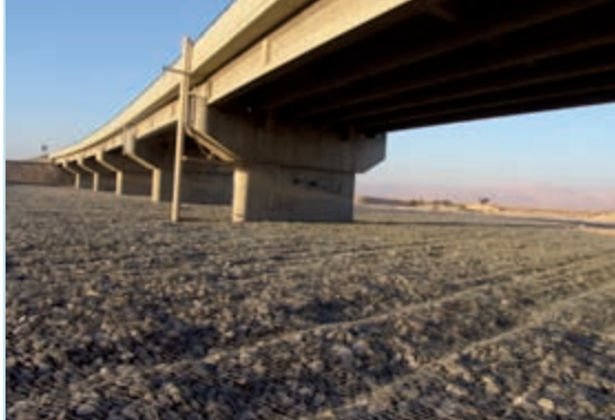
איור 6.6: מזרן גביונים יכול להקשות על תנועת בעלי חיים: רשת לכל רוחב הערוץ בנחל נקרות במעברו תחת כביש 90. שימוש בפתרון חלופי לבעיית הסחיפה או כיסוי חלק משולי השטח במצע המקורי של ערוץ הנחל יסייעו לבעלי החיים לנוע לאורך הערוץ ולחצות את תוואי הכביש. (צילום: רון פרומקין)
