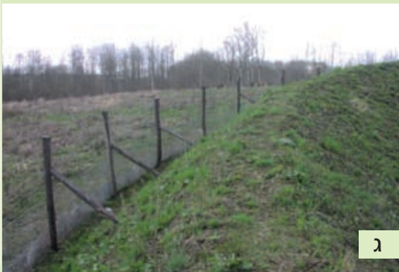
איור 7.17: שימוש באמצעים למניעת הפרעות: (א) פרט חתר המראה מסך הממוקם על סוללת עפר מוגבהת. בשוליים, בצדו הפנימי של המעבר, נטועים עצים או שיחים גבוהים. (איור: SP: P. Gaspar); (ב) שילוב בין גידור המנתב בעלי חיים לכיוון המעבר, מיסוך לצמצום ההפרעות מהכביש ומעבר צר להולכי רגל הממוקם מחוץ לגדר לכיוון הכביש. מעבר עילי בהונגריה. (צילום: תמר אחירון-פרומקין); (ג) סוללת עפר וגידור בשולי מעבר. (צילום: US: T. Clevenger)
