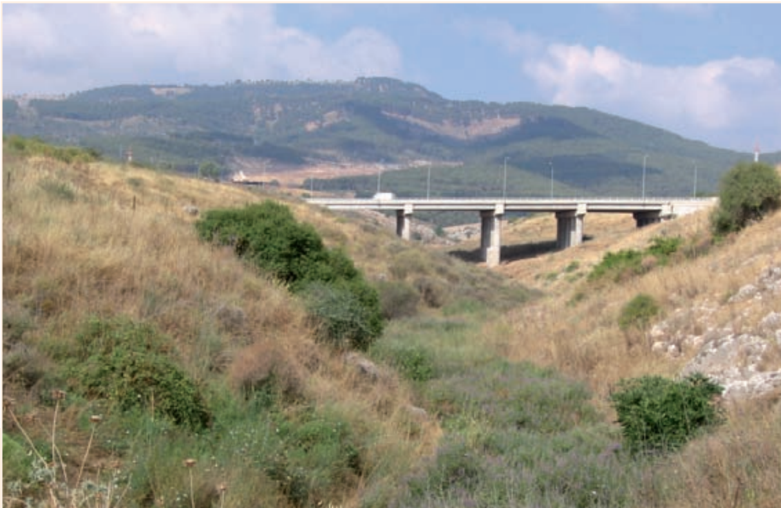
איור 1.2: גשר המשמר קישוריות בערוץ נחל: כביש 90 עובר בגשר מעל ערוץ נחל דישון. (צילום: דותן רותם)
