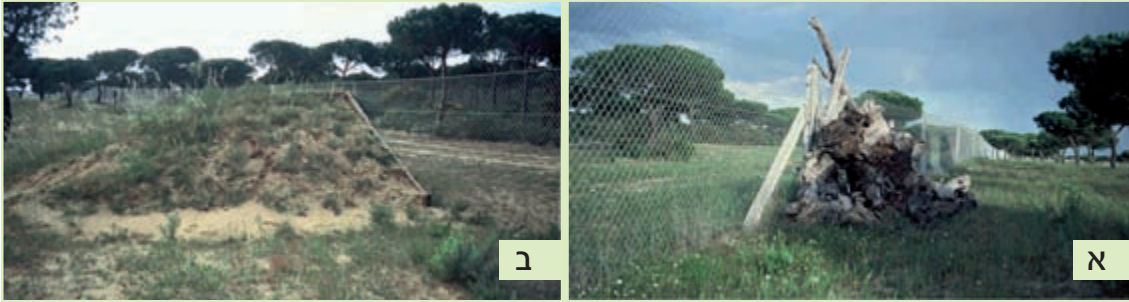
איור 7.74: פתחי מילוט לבעלי חיים שנלכדו בצדה של הגדר הפונה לכביש: דוגמאות מזרח ספרד לרמפות המאפשרות ליונקים לנתר אל מעבר לגדר: (א) יציאה פשוטה הבנויה מערמה של בולי עץ, מיועדת ללינקס; (ב) קרקע משופעת, "מקפצה" המיועדת למינים אחרים של בעלי חיים. ליציאת חזירי בר שנלכדו ברצועת הכביש אפשר למקם בחלקה התחתון של הגדר שער חד-כיווני (מעץ או ממתכת, יכול להיות מופעל קפיץ). (צילומים: EU: H. Bekker)
