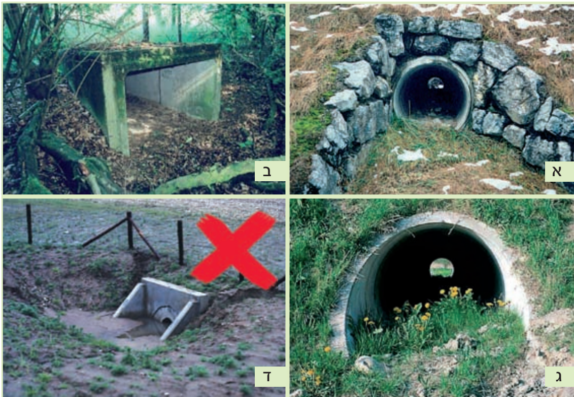
איור 7.56: דוגמאות לתכנון מעבר תחתית לבעלי חיים קטנים: (א) כניסה למעבר תחתית לבעלי חיים קטנים (קוטרו מטר אחד). קירות אבן, שבאזור הררי זה הם מאפיין נפוץ, מובילות בעלי חיים למעבר, שוויץ (צילום: EU: A. Righetti); (ב) מעבר מרובע לבעלי חיים קטנים שרוחבו 1.2 מ', גובהו 0.8 מ' ואורכו 40 מ'; גרירות משתמשות במעבר זה באופן תכוף. הולנד (צילום: EU: H. Cormont); (ג) צינור שתוכנן כמעבר לבעלי חיים קטנים. תחתיתו מולאה באדמה, אולם כיוון שקוטרו מטר אחד בלבד הוא קטן למדי. גרמניה (צילום: EU: V. Keller); (ד) מנהרה זו נסתמה בחול ובמים. הלקח שנלמד מכך הוא לבנות את המנהרה מעל מפלס מי התהום ולבנות שיפועים יציבים סביב הכניסה. הולנד (צילום: EU: H. Bekker)
