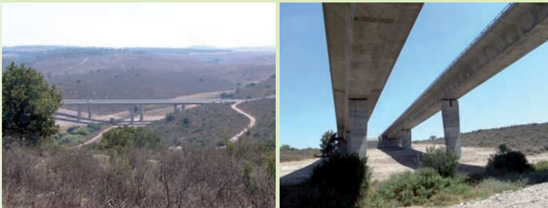
איור 7.41: שמירה על רצף בתי גידול, המשכיות ערוץ הנחל וצומח הגדות: על ידי שילוב בין שני גשרים ארוכים מעל הנחלים שלף ודליה, ובהמשכם מעבר רצף בכביש חוצה ישראל ברמת מנשה (למעלה). בתמונות למטה נראה הגשר מעל עמק נחל דליה, החוצה את ערוץ הנחל, שטחים חקלאיים, דרכים חקלאיות ושטחי בתה וגריגה. (צילומים: רון פרומקין)
