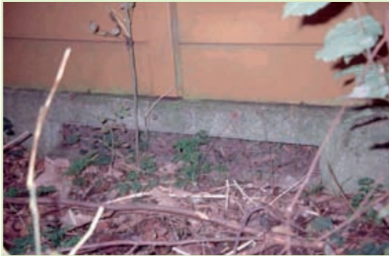
איור 7.81: למחיצה אקוסטית זו יש פתחים בבסיסה כדי לצמצם את אפקט החיץ עבור בעלי חיים קטנים. (צילום: H. Bekker, EU)
