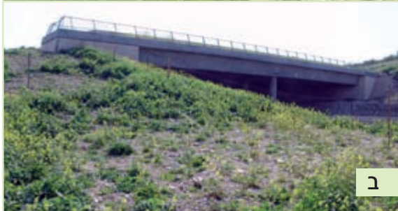
איור 7.21: מעבר עילי לבעלי חיים מעל כביש 70: אפשר לשפר את הנגישות של בעלי החיים למעבר על ידי עיצוב נוסף של השיפועים והצומח בהם שסייעו למינים קטנים וניידים פחות לחצות את נחל תות המקיף את הכניסה הצפונית למעבר. (צילומים: רון פרומקין)
