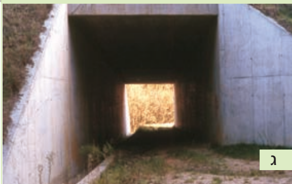
איור 7.50: דוגמאות לשילוב תפקודים למעבר אדם ובעלי חיים במעבר התחתי: (א) דרך סלולה ורצועות צומח מתחת גשר. הפתח בין שני הנתיבים מקנה תחושה של פתיחות ומאפשר תאורה טובה יותר לצומח; (ב) מעבר חקלאי בנחל גוברין. (צילומים: רון פרומקין); (ג) מבנה המשלב מעבר בעלי חיים עם דרך יער. (צילום: SP: F. Navàs, Minuartia)
