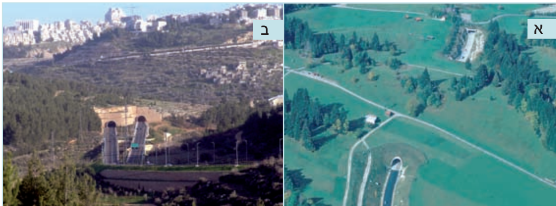
איור 6.10: מנהרות חפורות: (א) בנוף גבעי בבואריה, גרמניה. (צילום: EU: B. Georgii); (ב) בכביש 9 בעמק הארזים ליד ירושלים. המנהרה נחפרה בצדי גבעה במצפה נפתוח ולפני הכניסה אליה עובר הכביש בגשר מעל נחל שורק. (צילום: רון פרומקין)
