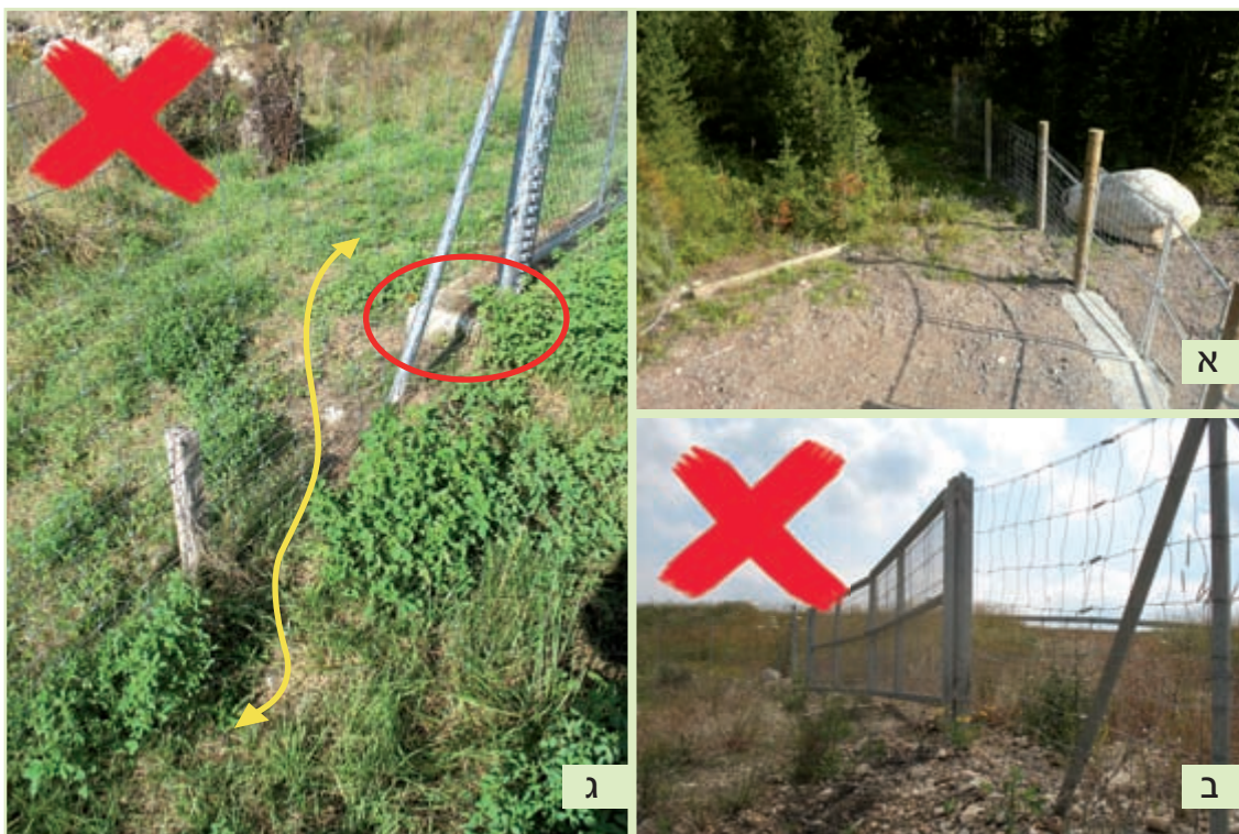
איור 7.75: בסיס מוטון תחת שער בגדר: (א) אמצעי זה מומלץ למניעת חפירה תחת השער (צילום: US: T. Clevenger); (ב) שער שירות שמאפשר הידחקות או חפירה וכניסה תחתיו; (ג) אין די בביסוס השער במוטון (מסומן בעיגול): אם הגדר אינה מעוגנת בקרקע ב"שמלה", ייתכן מעבר של בעלי חיים תחת הגדר לצד השער (נתיב תנועה העובר תחת הגדר מסומן בקו). (צילומים: תמר אחירון-פרומקין)
