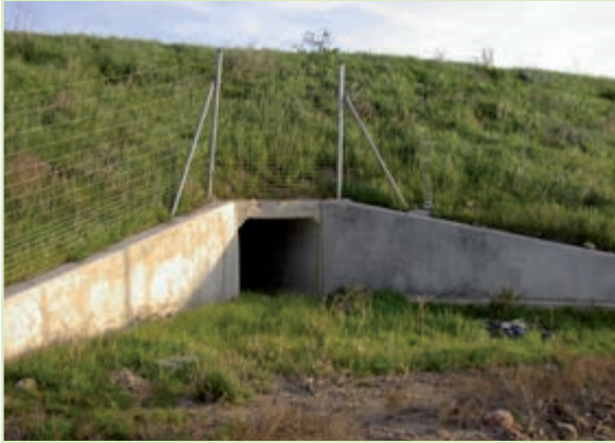
איור 7.55: מעבר תחתי לחולייתנים בינוניים וקטנים: ניתוב בעלי החיים למעבר התחתי נעשה על ידי שולי המעבר המשתפלים ונפתחים לסביבה ועל ידי הגידור המוקפד. (צילום: SP: F. Navàs, Minuartia)
