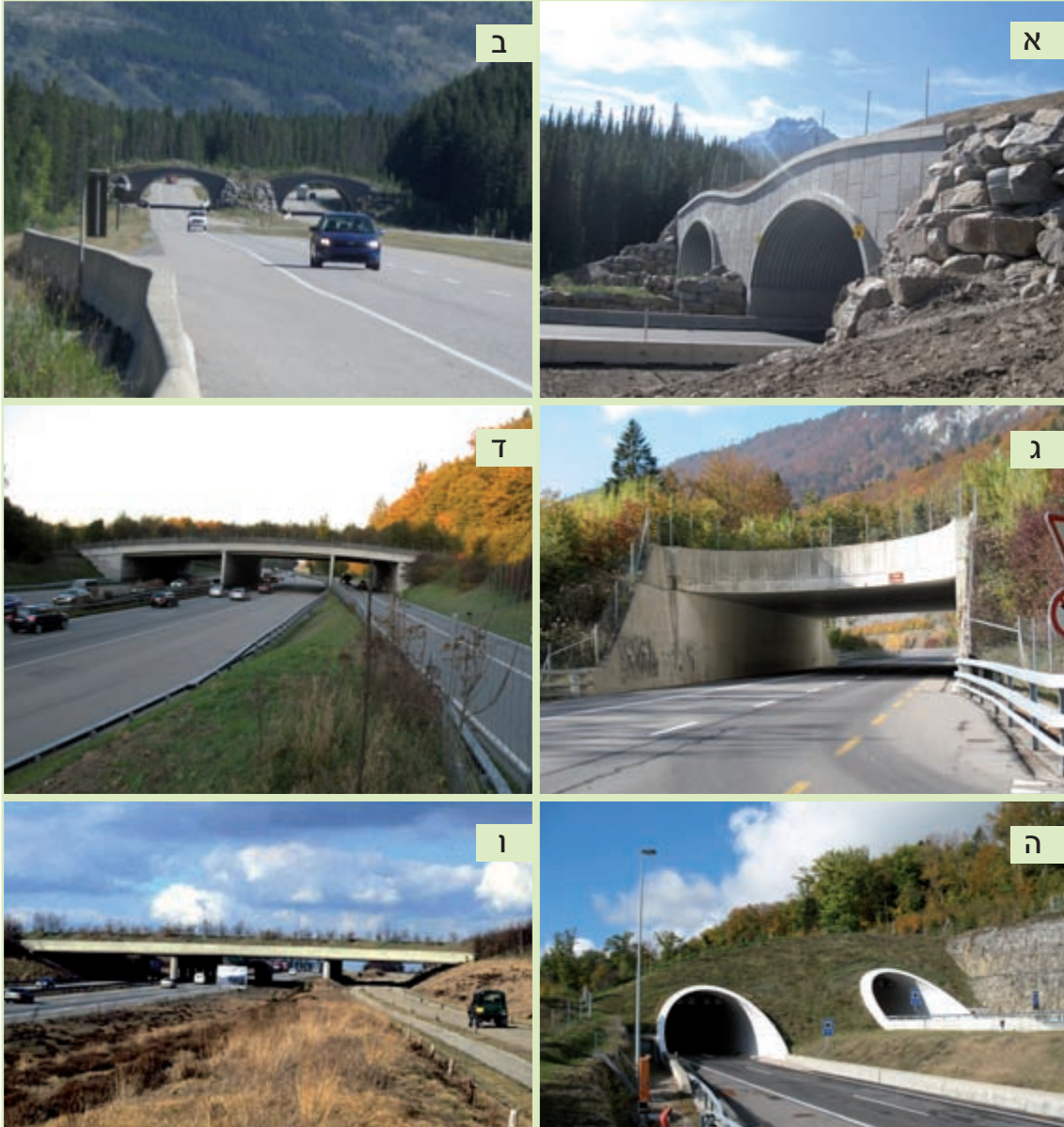
איור 7.13: מגוון עיצובים למעברי רצף בנויים: שימוש באלמנטים מוכנים שהונחו על כביש מהיר קיים – מעבר במהלך בנייה (א) ומעבר מתפקד (ב) – אזור Banff, הכביש המהיר החוצה את קנדה; (ג) מבנה שעון חול למעבר צר וקצר הבנוי בשיפוע, בנוף הררי על כביש כפרי, שווייץ; (ד) מעבר מעל כביש מהיר שלצדו כביש כפרי, מצפון לברן, שווייץ. במעבר זה הוקפד לשמר את הקישויות גם לשטח הכלוא בין הכביש המהיר לבין מסילת רכבת העוברת במקביל אליו ולשטחים שמעבר למסילה; (ה) מעבר רצף שנבנה בשיפוע, עם מסלולים במפלסים שונים, שווייץ (צילומים: תמר אחירון-פרומקין); (ו) מבנה בטון ישר המוצב על עמודים, מצפון לארנהם, הולנד. הכביש הונמך כדי לאפשר למעבר להיות במפלס אחד עם השטחים הסובבים. (צילום: EU: V. Keller)
