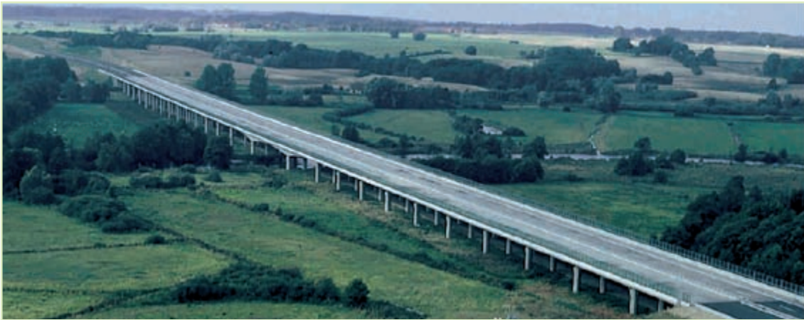
איור 7.40: ויאדוקט נמוך המשמר שטחי ביצה ומישורי הצפה של נהר: גשר ארוך מאפשר המשכיות צומח ובתי גידול וכן שימושי קרקע מרובים: אזור נמוך שבו עובר אפיק זרימה, שטחים נטועים, חקלאיים או טבעיים. במקום לבנות סוללה נבנה הכביש המהיר A20 בצפון גרמניה על עמודים. (צילום: DEGES; EU)
