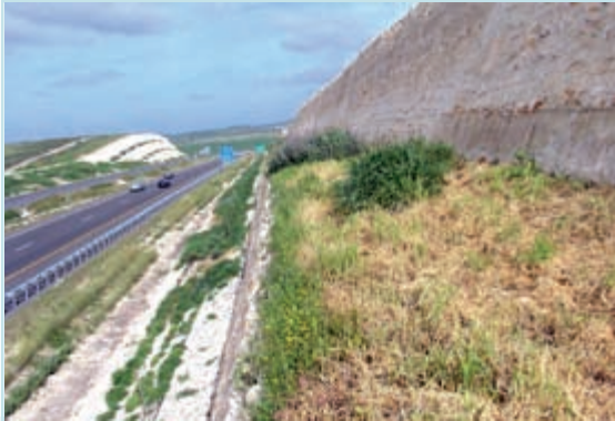
איור 6.8: דירוג מדרונות מספק הזדמנויות ליצירת בתי גידול: איור הברמות בקטע 18 של כביש חוצה ישראל וכיסויין באדמה מקומית מיתן את השפעת החפירה ואפשר התחדשות הצומח הטבעי המקומי במעין "איים מוגנים". (צילום: רון פרומקין)
