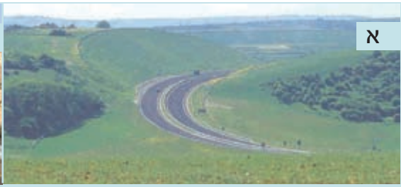
איור 6.2: שיפועים מתונים מסייעים להתמזגות הכביש בנוף: (א) מעקף A27 בבריטון, דרום אנגליה. למען שימור טבע ונוף, תוואי הכביש עובר בשולי גבעות באזור. דירוג החפירות והסוללות לשיפוע של 1:6 מאפשר להתאים את הכביש למאפייני הנוף. (צילום: הגבעות המקיפות את נחל בוקר. (צילום: תמר אחירון-פרומקין) (EU: Highways Agency, UK); (ב) כביש 40 בין רכס חלוקים לצומת טללים משתלב בטופוגרפיה ומטפס באופן מתון במעלה
