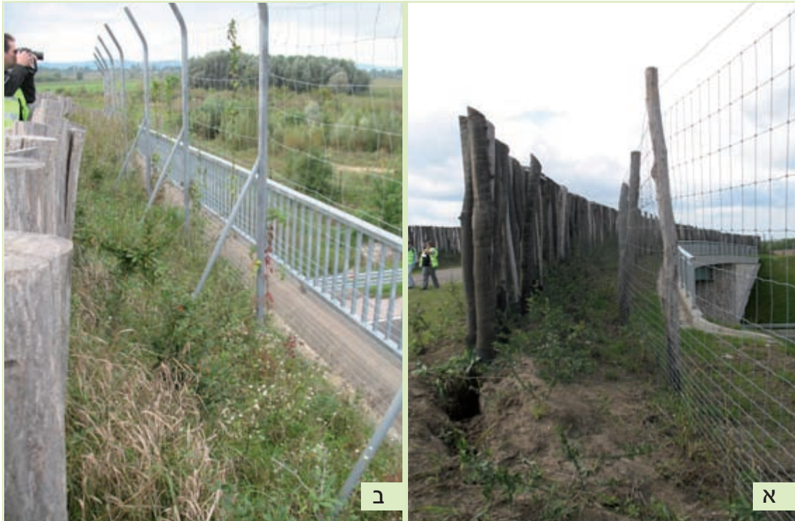
איור 7.25: הפרדה בין שביל להולכי רגל לבין המעבר עצמו: מעבר צר להולכי רגל תחום במעקה וממוקם בצד הפונה לכביש, מחוץ למחיצה ולגידור בשולי מעבר עילי לבעלי חיים בהונגריה. (צילומים: תמר אחירון-פרומקין)
