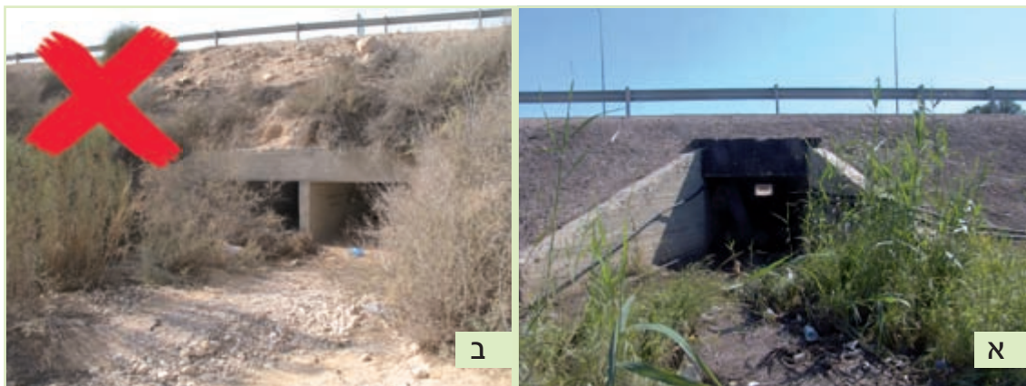
איור 7.79: ריכוז צומח בכניסה למעברי המים: צומח זה מאפשר מחסה ונגישות בטוחה יותר לבעלי חיים קטנים. (א) רצוי לא להסתפק בנוכחות של צומח חד-שנתי בלבד. (צילום: רון פרומקין); (ב) לתפקוד יעיל של הצומח בכניסה למעבר חשוב להקפיד שסחופת צומח לא תחסום את הכניסה ושפסולת לא תילכד בסבך הצומח. (צילום: תמר אחירון-פרומקין)
