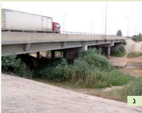
איור 7.53: דוגמאות בתכנון מעבר תחתית עם זרימת מים: (א) נתיב זרימה לצד דרך סלולה וביניהם נתיב מעבר לא סלול בכביש 6 העובר מעל אחד מיובלי נחל איילון; (ב) גשר עות'מני המאפשר מעבר יבש לצד הנחל, כביש 75 מעל הקישון. הנחל זורם על פני סלע טבעי חשוף; (ג) גשר רחב המאפשר תנועה של בעלי חיים לאורך גדת הנחל, תנועה ברצועת צומח הגדות ששומרה ותנועה בערוץ הנחל כשהוא יבש. גשר מעל נחל איילון, כביש 412. (צילומים: רון פרומקין)
