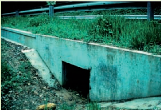
איור 7.64: פתחה של מנהרה מרובעת, עם קווים מתעלים מחוברים בקפידה. גרמניה (צילום: EU: J. Niederstrasser)
