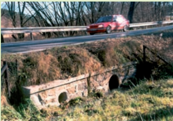
לטורות אינן אוהבות מעברי מים מוצפים בלא חלקים יבשים. בצניורות קטנים הממוקמים מעל מפלס המים במקביל למעביר המים, כדוגמת זה בצ'כיה, נעשה שימוש סדיר. (צילום: (EU: V. Hlaváč
