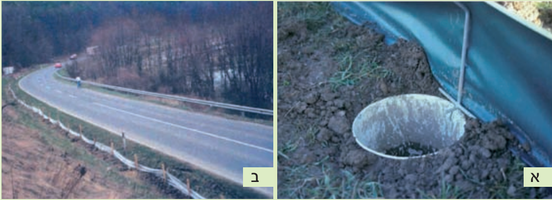
איור 7.67: דוגמה להתקנים ארעיים למעבר דו-חיים: (א) דלי לאיסוף דו-חיים. הדלי ממוקם בקרבת הגדר כדי למנוע אפשרות שבעלי החיים יעברו אותו מבלי להילכד. (צילום: EU: P. Schlup); (ב) גליל פלסטיק אטום וחזק אפשר להציב ללא צורך ברשת תיל מייצבת, כמו בדוגמה זו מהונגריה. את העמודים יש למקם בצד המנוגד לאזור הגישה של הדו-חיים (בצד הפונה לכביש) כדי לשפר את יכולת הניתוב של הגדר. (צילום: EU: M. Puki)
