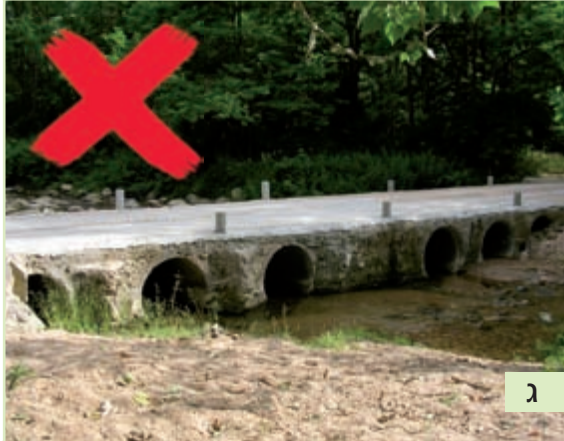
איור 7.63: דוגמאות לתכנון מעברים לדגים: (א) מעביר מים על ערוץ זרימה המאפשר תנועה חופשית של דגים. (צילום: SP: C. Rosell, Minuartia); (ב) מעבר המתאים לדגים ("סולם דגים") בשלבי הקמה. (צילום: דידי קפלן); (ג) הניקוז מפוצל למבנים צינוריים המקשים על מעבר דגים. (צילום: SP: F. Navàs, Minuartia)
