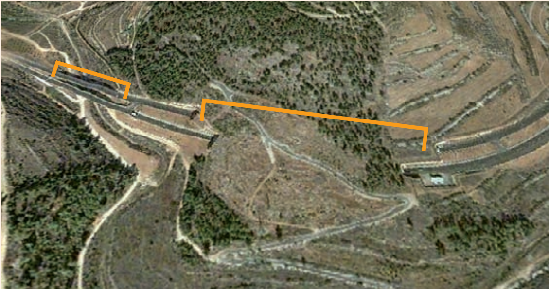
איור 1.1: דוגמה לאמצעים שאפשר להשתמש בהם למזעור ולמיתון השפעות שליליות של הקיטוע על מערכות אקולוגיות: שילוב בין מנהרה העוברת בגבעת מצפה נפתוח (במרכז התמונה) לבין גשר (משמאל) מעל נחל שורק בכביש 9 העובר בעמק הארזים למרגלות הכניסה לירושלים.
